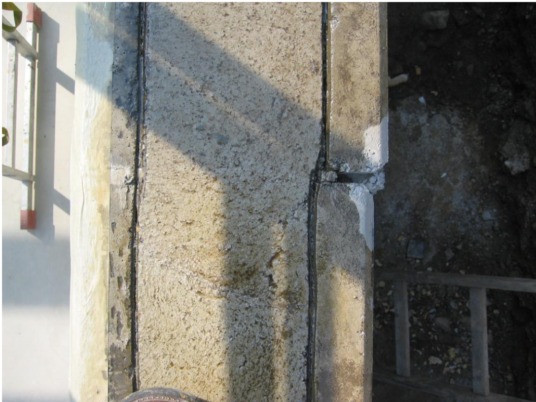
10-Unterschiedliche Wanddicken >>> 29 und 31cm
