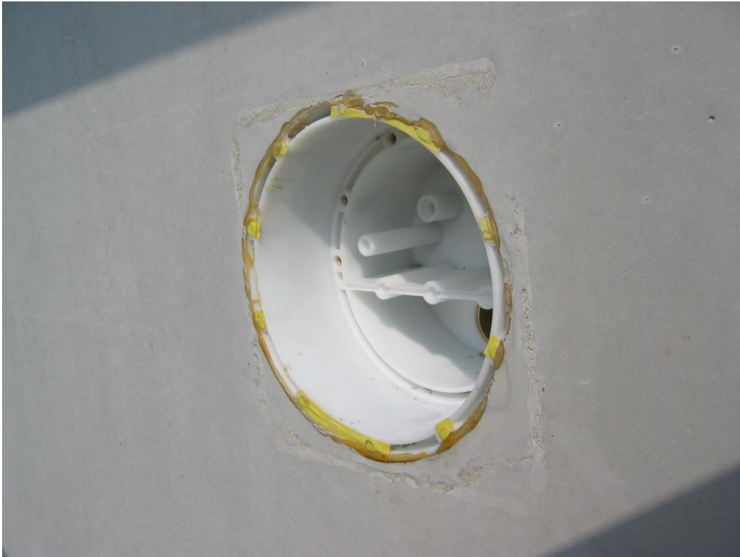
6- Einbauteil der Gegenstromanlage ist nicht mittig eingebaut
