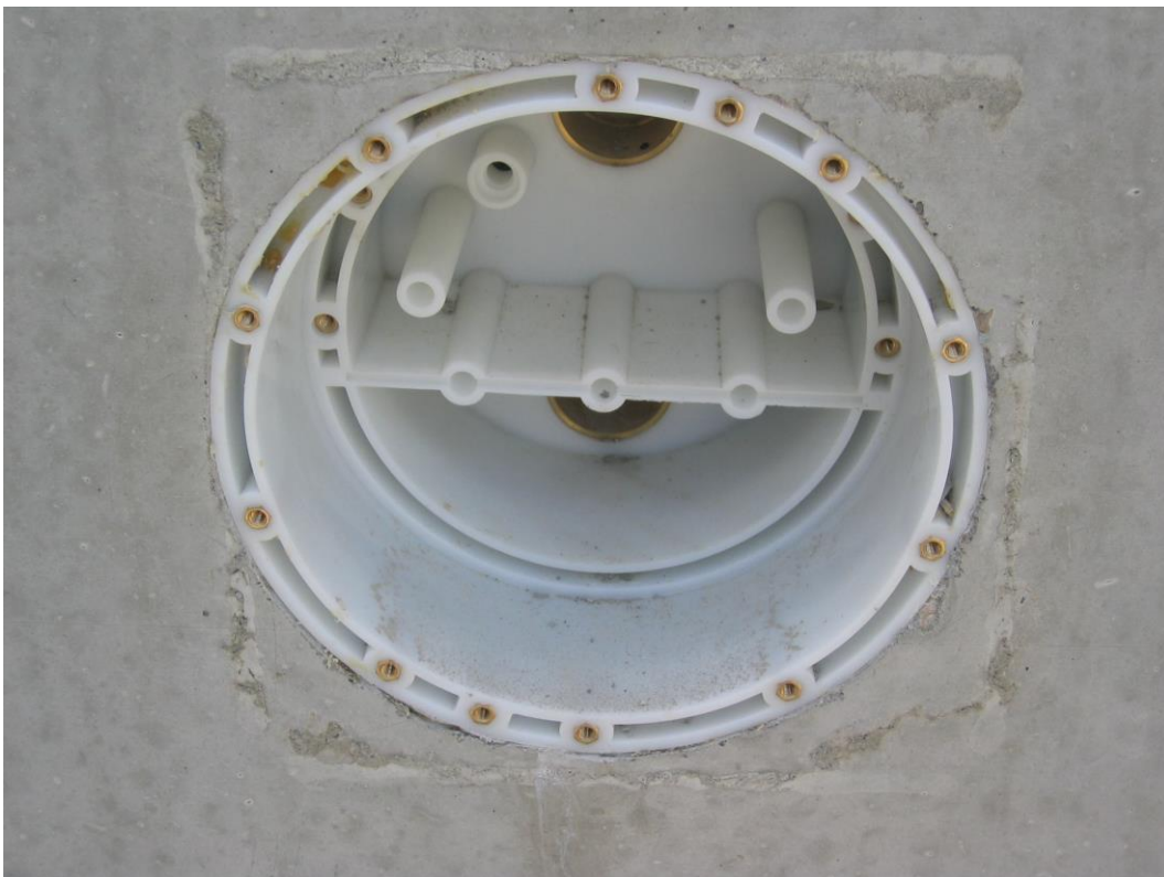
6- Einbauteil der Gegenstromanlage ist nicht mittig eingebaut
